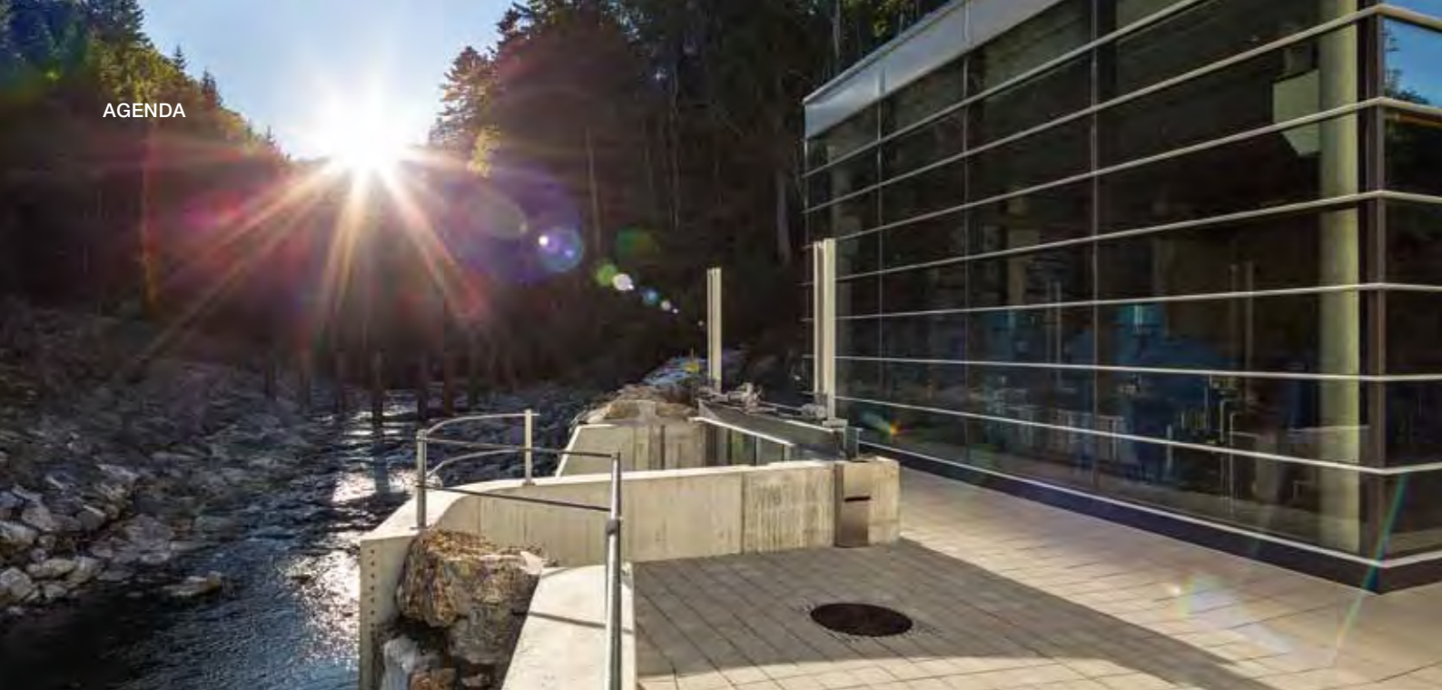
Kleinwasserkraftanlage in Blaichach (Deutschland) mit einer umweltfreundlichen Wasserführung am Einlauf.
