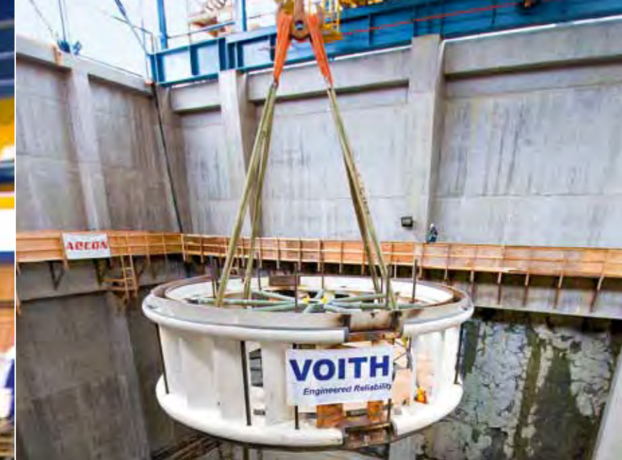
Der Traversenring wird auf den Turbinenboden herabgelassen.
