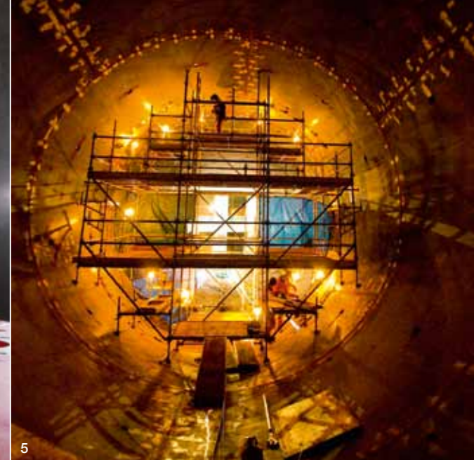
4 Abnahme neu eingetrossener Ausrüstung: Marc Gagnon steht in einem der Turbinendeckel. 5 Arbeiter in der Druckrohrleitung, die fast die Ausmaße eines U-Bahn-Tunnels hat.
