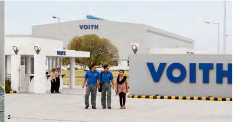
1 Halle im Turbinenfertigungswerk in Vadodara. 2 Voith-Indien-Mitarbeiter bei der Arbeit. 3 Stolz auf den Namen Voith: Der Standort Vadodara. von außen
