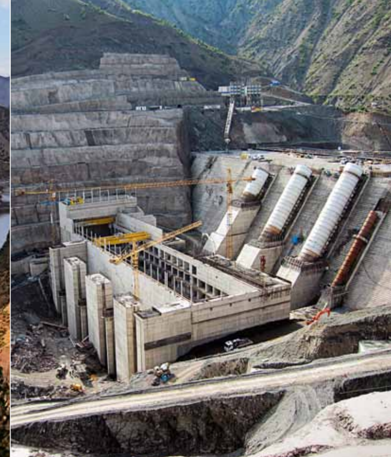
Beyhan I ist das erste von vier Wasserkraftwerken in diesem Abschnitt des Flusses Murat. Voith Hydro stattet die Anlage mit drei Generatoren aus.
