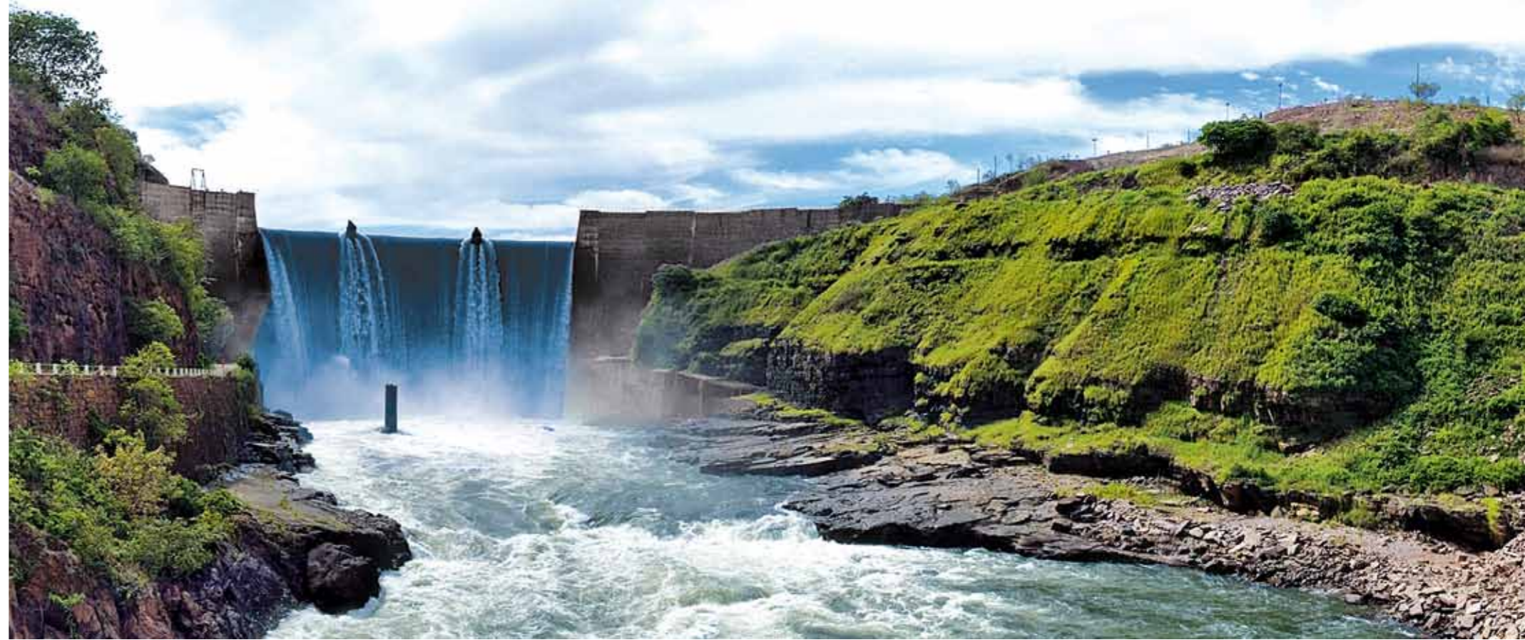
Voith hat das Wasserkraftwerk Cambambe am Kwanza-Fluss modernisiert. Nun ist ein zweites Kraftwerk für die Region geplant.
