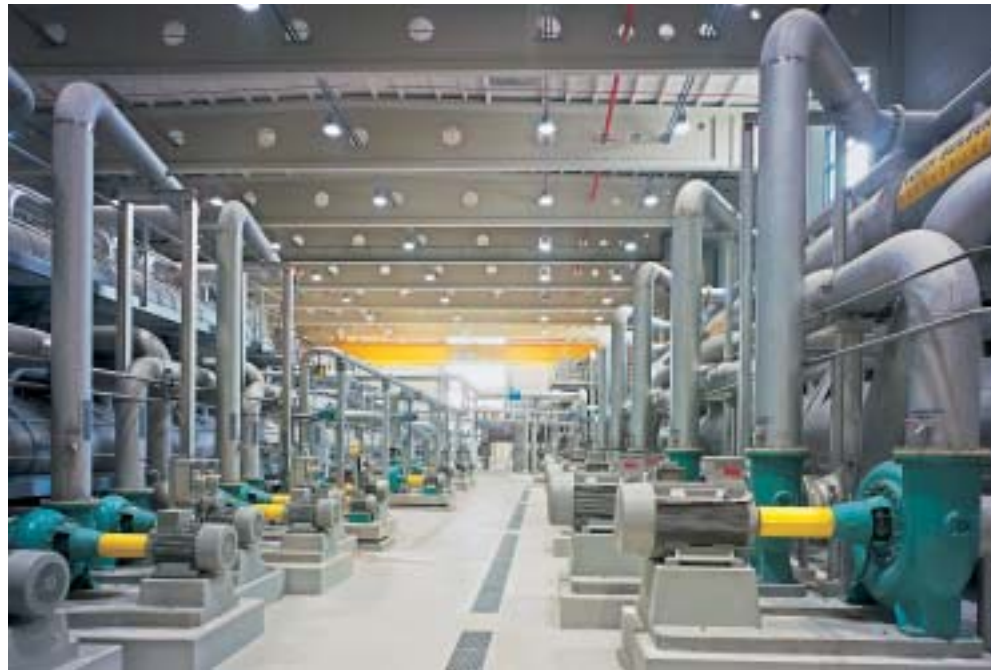
Abb. 4: Rechts die Primärzellen der Flotation I und II und links die Sekundärzellen der Flotation I und II sowie die Stickies-Flotation. Es wurde in der gesamten Anlage hohen Wert auf eine besonders gute Zugänglichkeit für Service-Zwecke gelegt.
