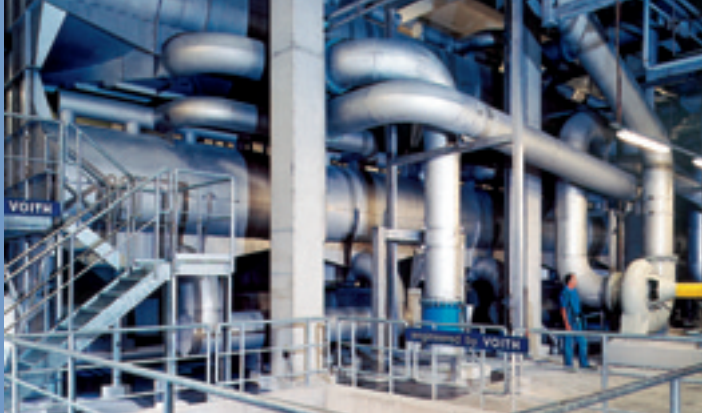
Abb. 3: EcoCell Vor- und Nachflotation.
