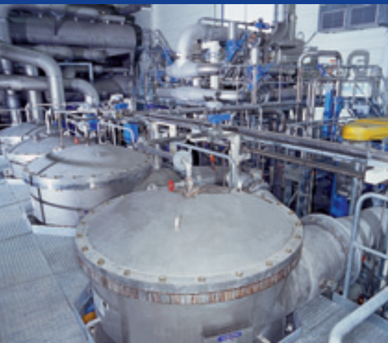
MultiSorter Grob- und MultiScreen Feinsortierung, ausgerüstet mit C-bar Siebkörben und MultiFoil-Rotoren.
