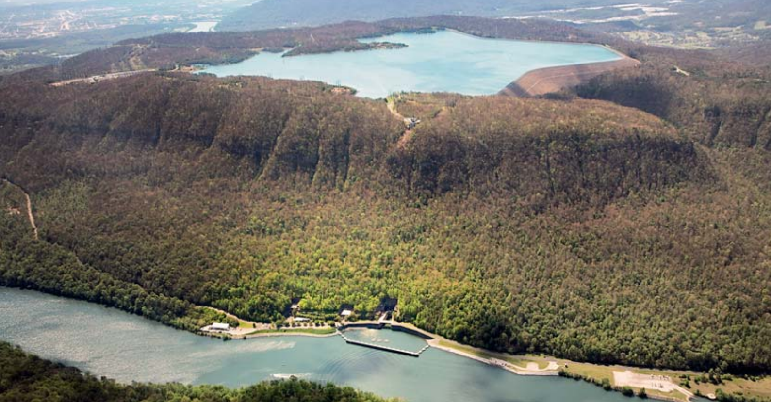
Blick auf das Pumpspeicherwerk „Raccoon Mountain“ am Tennessee River.
