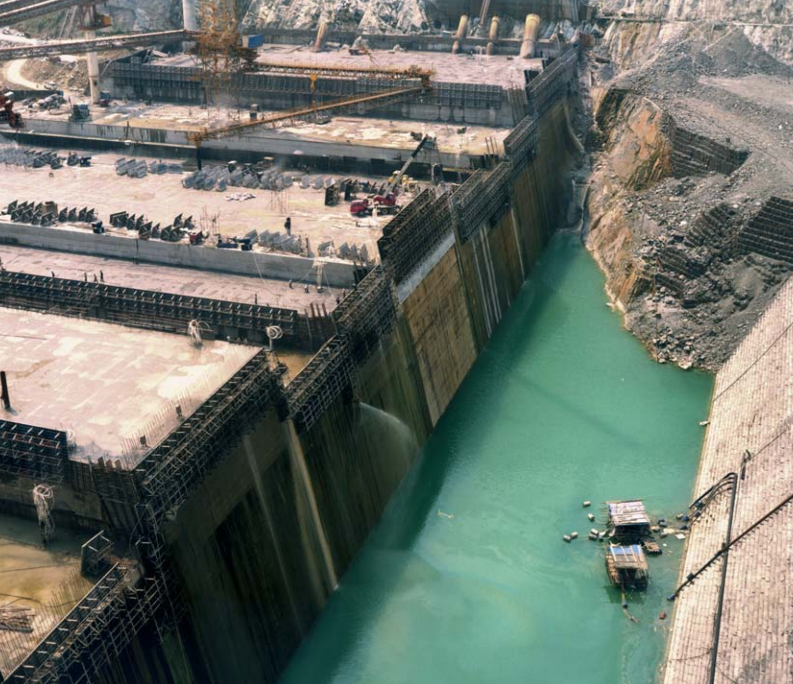
Bau des Kraftwerks „Long Tan“ am Fluss Hongshui.
